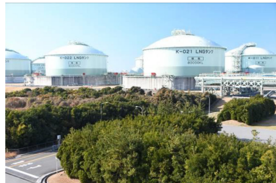
LNG receiving terminal
