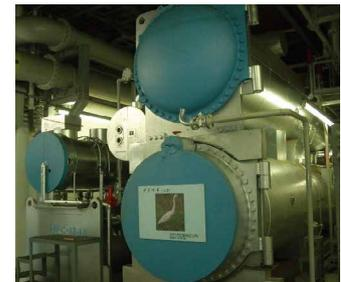
Bomba de Calor con el Aprovechamiento de Calor de Aguas Residuales
