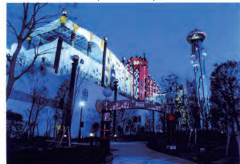
Antecedentes de generación por incineración de residuos en Japón Ejemplo de 450t/día x 2 unidades (32.000kW)
