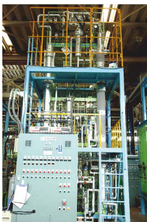
Рис. 3. Опытная установка (Исследовательский центр JGC в городе Оарай)
