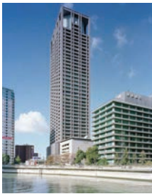
ЗДАНИЕ ЭЛЕКТРИЧЕСКОЙ КОМПАНИИ В КАНСАЕ Осака, Япония | Офис | 2005 г. Награды: Премия Nikkei за новые офисные здания
