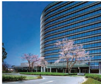
ГЛАВНЫЙ КОРПУС TOYOTA MOTORS Айти, Япония | Офис | 2005 г. Награды: Премия Ассоциации архитекторов Японии «За хороший дизайн»
