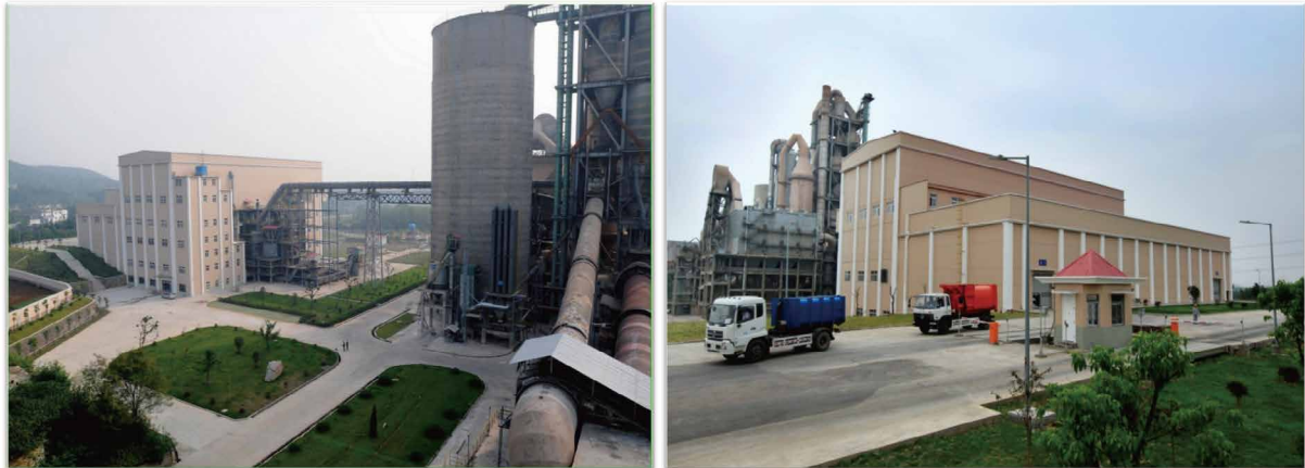
Система переработки отходов, использующая печь для обжига цемента (Китай, Тунлин, Conch Cement Co., Ltd.)
