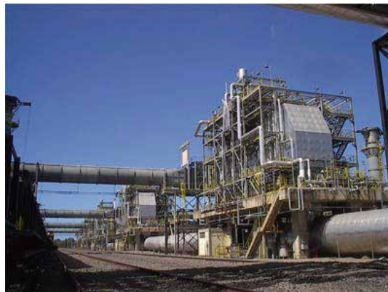
Электростанция на уходящем тепле от коксовой печи (SOL CST, Бразилия)
