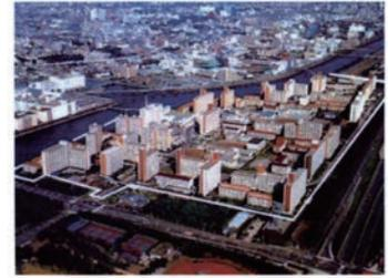
Мусороперерабатывающий завод Shinagawa в Токио не только вырабатывает 15 000 кВт электроэнергии, но и обеспечивает теплоснабжение более 5 000 домашних хозяйств в соседнем жилом комплексе Yashio в основном для отопления и горячего водоснабжения. (Фотография с веб-сайта Ассоциации коммунального теплоснабжения Японии)
