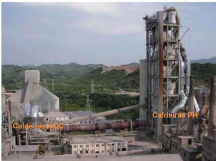
Usina de recuperação do calor de exaustão para fábrica de cimento (CONCH Cement, China)
