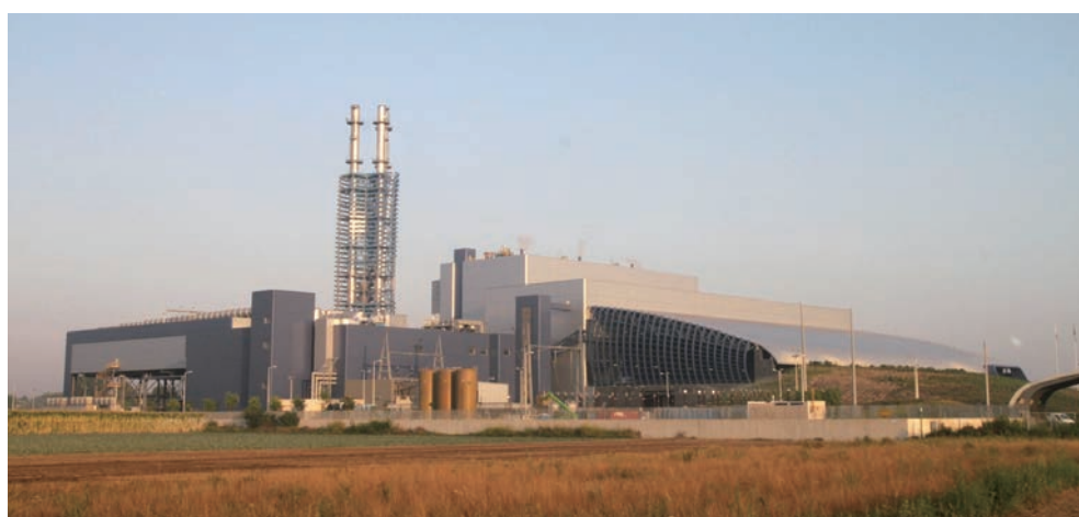
Vista Exterior da Instalação (Nápoli, Itália) (Fonte : Companhia "Steinmüller Babcock Environment GmbH")
