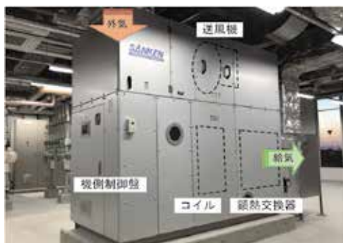
● 動力盤など、運転に必要なものを全て内蔵したオールインワンユニット「エコサラ®」
