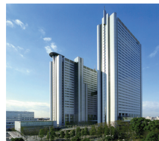
NEC 玉川ルネッサンスシティ 神奈川県 | 事務所 | 2005 年 受賞：BCS 賞，日経ニューオフィス賞，地 球環境大賞，日経優秀先端事業所賞，SDA 賞，環境・賞エネルギー建築賞，空気調和・ 衛生工学会賞，電気設備学会賞，JIA 環境賞， エコビルド賞
