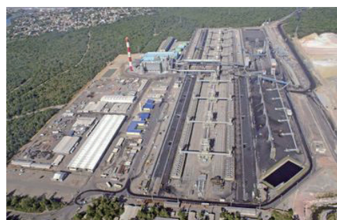
コークス炉廃熱発電設備 (ブラジル ARCELOR-MITTAL-TUBARAO 製鉄所)
