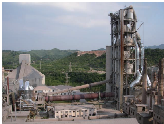
セメント廃熱発電設備 (中国 CONCH セメント)
