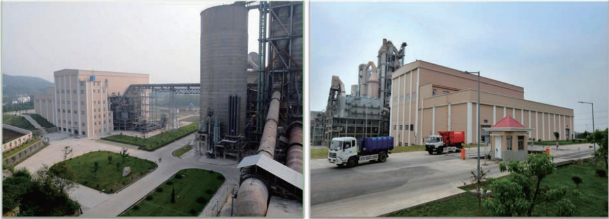
利用水泥窑的垃圾处理系统（中国 铜陵海螺水泥有限公司）
