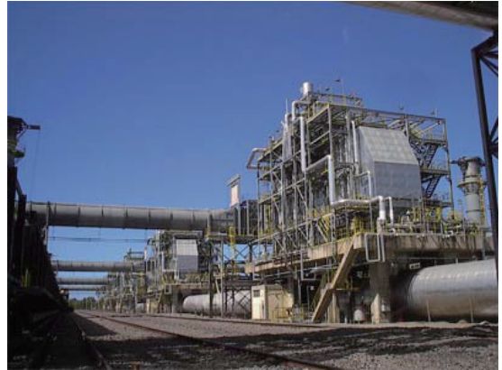
焦炉废热发电设备 （巴西SOL CST）
