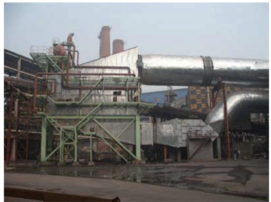
烧结冷却机废热发电设备（中国武汉钢铁）
