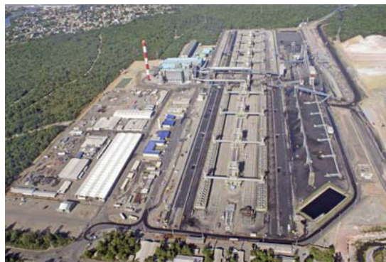
焦炉废热回收发电设备 (巴西 SOL CST)
