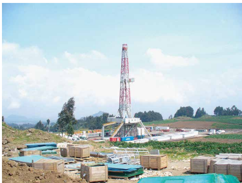
调查挖掘现场(卢旺达)
