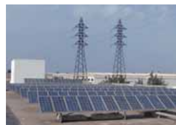
ONE (Escritório Nacional de Electricidade) Casablanca, Marrocos
